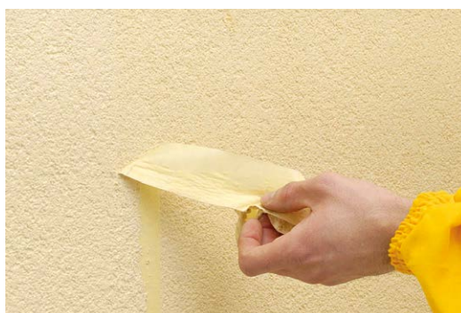
Krohvimise katkestamisel tuleb liitekoht vormistada teibi abil
